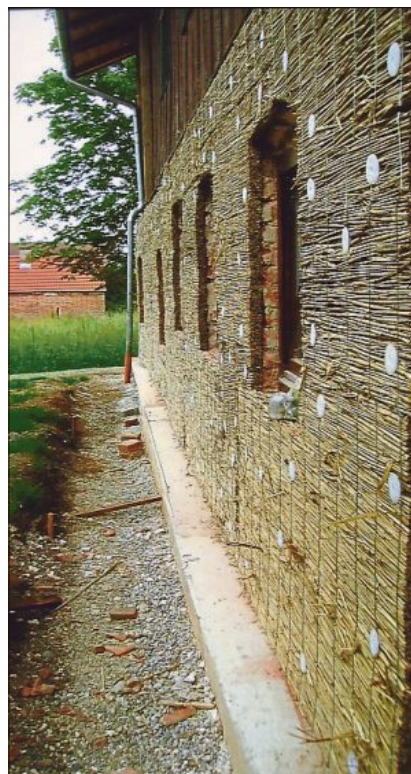
Dämmen mit Schilfrohr (Bild: Privat)
